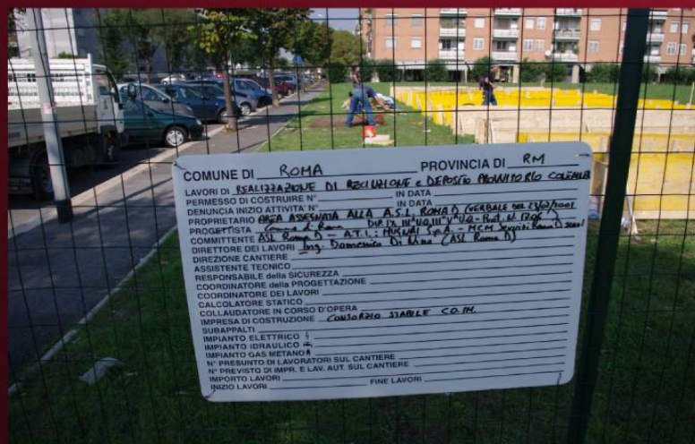
Fermata l'installazione di container al centro del quartiere.
