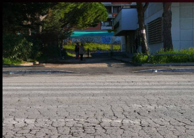
Realizzato il passaggio per disabili alla posta di via Bocchi.
